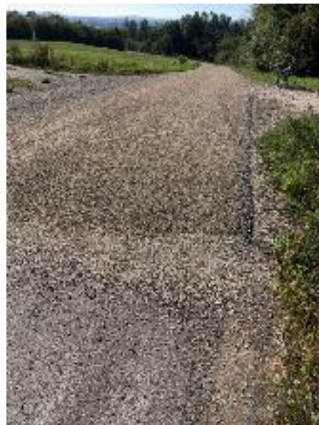
gravillonnage rue de la chapelle
